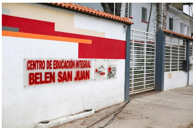
Figura 2. Fachada del CEI “Belén Sanjuán”.
